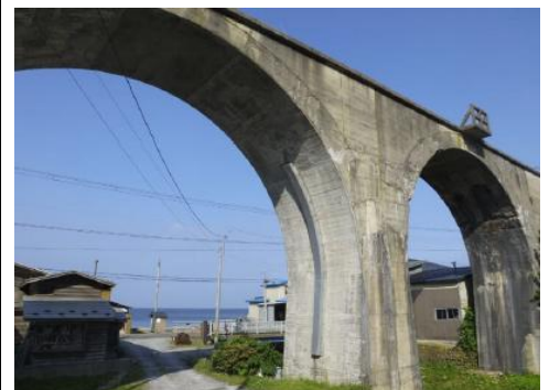
工事途中で放置された大間鉄道のアーチ橋
