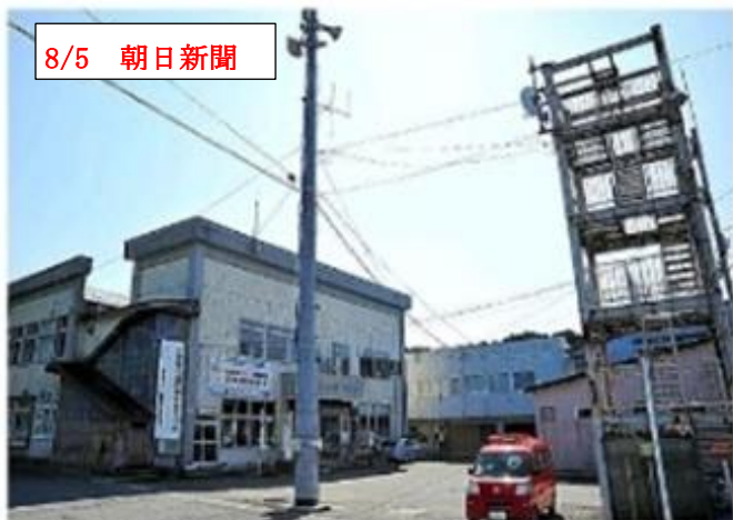
移転・建て替えが議論されている風間浦村役場（左）と消防庁舎
