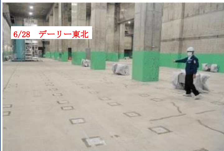
むつ市の使用済み核燃料中間貯蔵施設の内部。審査の終了が近づくが、事業開始時期は見通せない＝2022年10月
