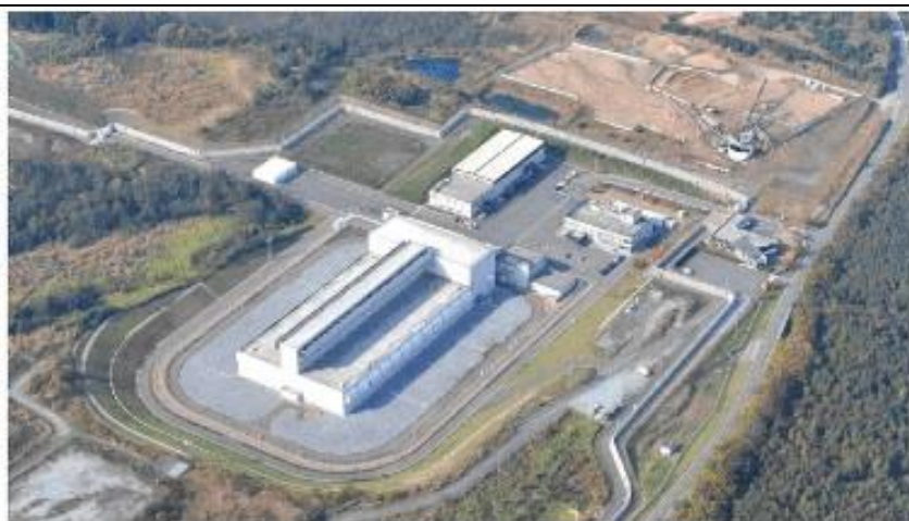
核燃新税が焦点となっている使用済み核燃料中間貯蔵施設「むつ市」
