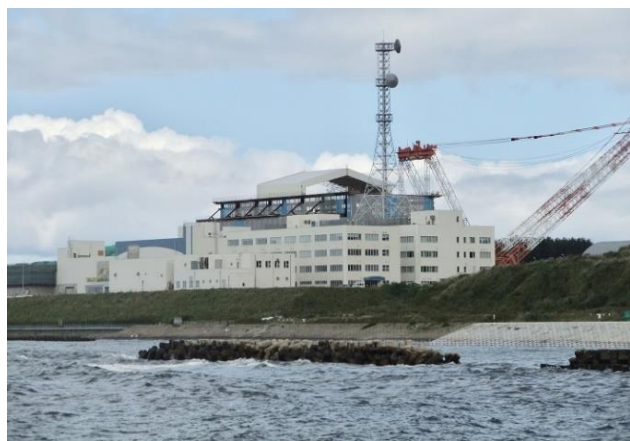
工事竣工率37%のままの大間原発
