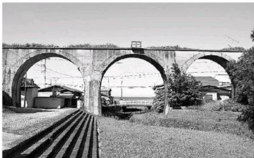
⑦完成したものの、大間鉄道自体が頓挫したため放置された巨大なアーチ橋。「二枚橋橋梁」と呼ばれている＝いずれもむつ市大畑町
